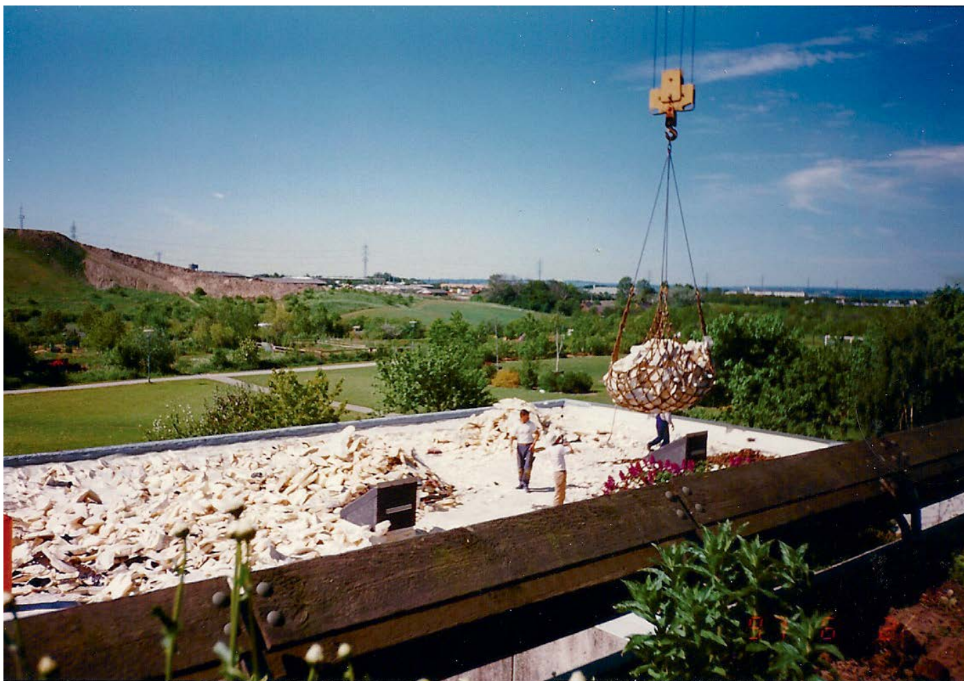
Isolringsskummet fra første renoveringsforsøg fjernes.
