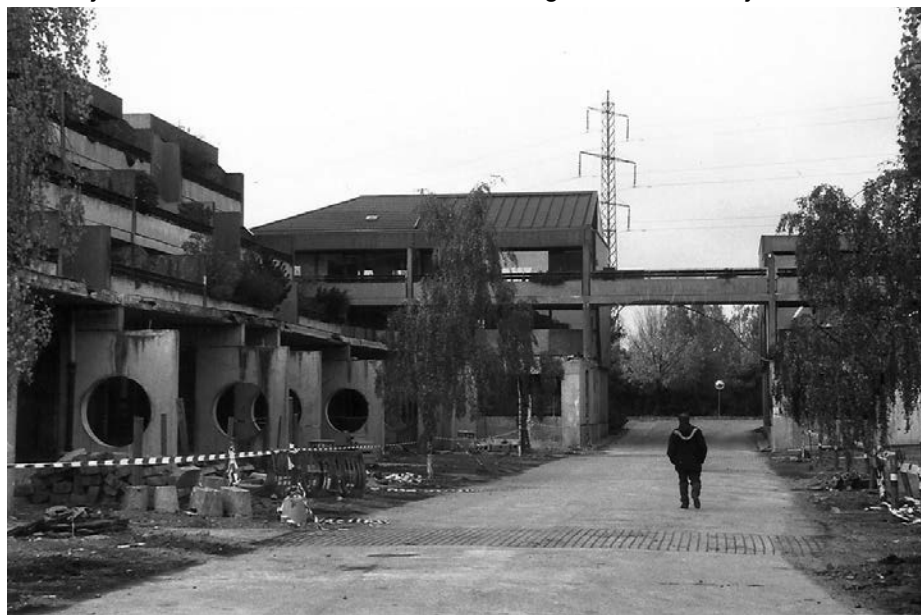
Carportdækket er nu taget ned (udateret).
